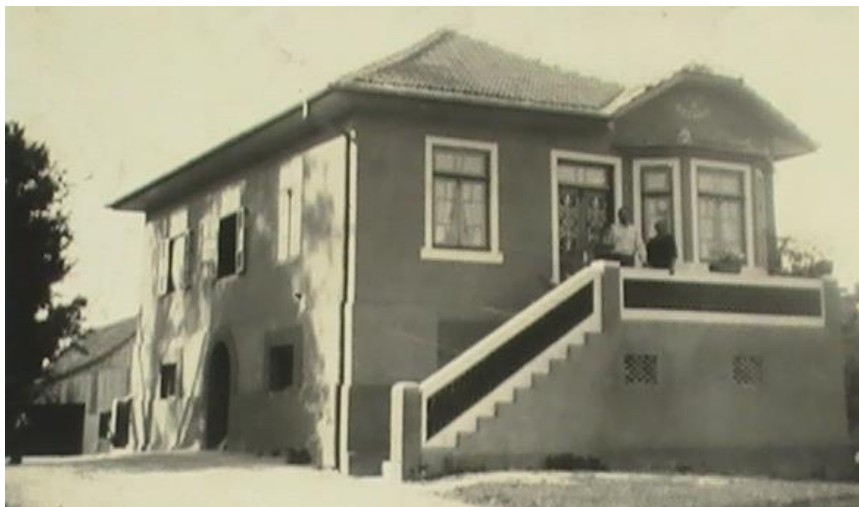
Casa di Lodovico ristrutturata (raccolta di Amauri do Rosário)
